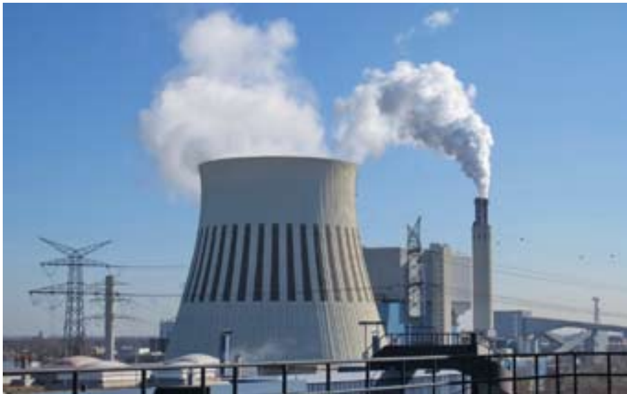
Das Heizkraftwerk „Reuter West“ in Siemensstadt. Wie es mit der Energiewende und dem Klimaschutz in Berlin aussieht, beschreibt Monika Götze auf Seite 17
