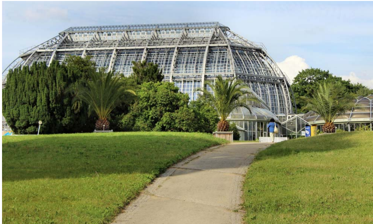
Botanischer Garten in Steglitz-Zehlendorf: Das lange geschlossene Viktoriahaus wurde mit Mitteln der EU saniert und wiedereröffnet.
