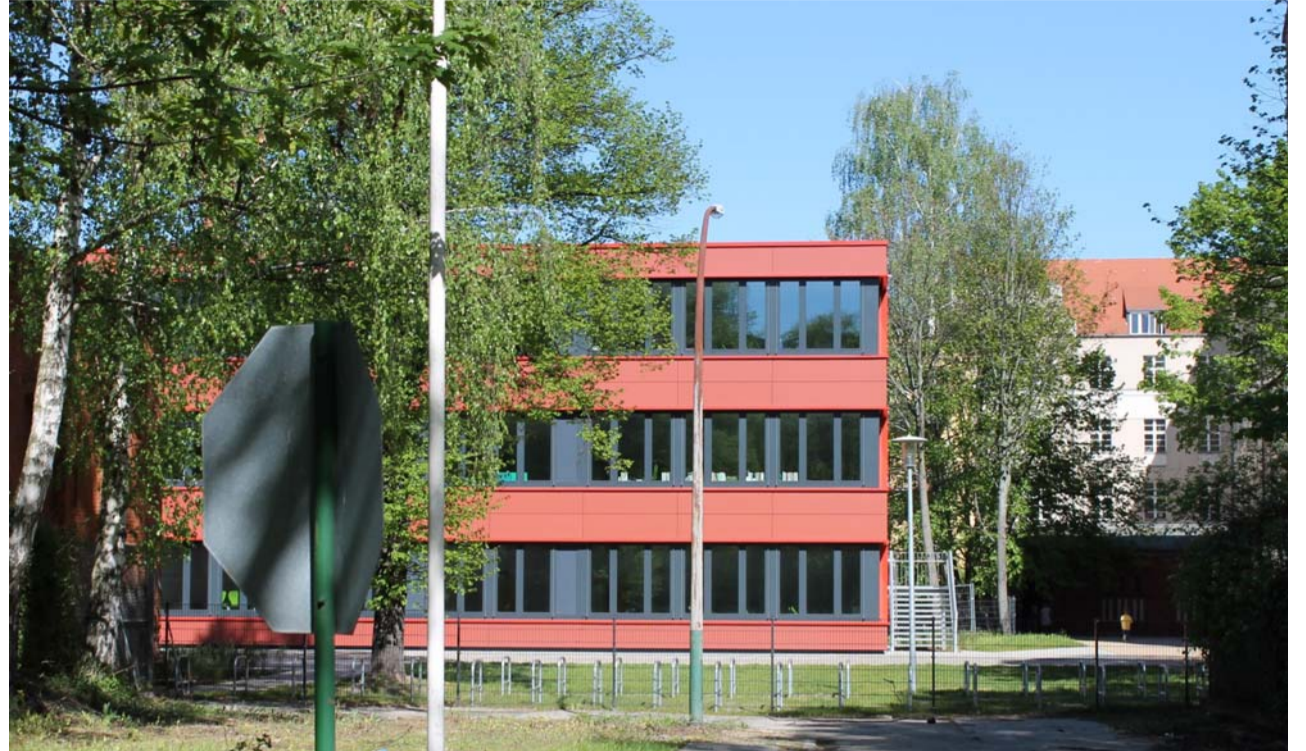
Die Elizabeth-Shaw-Grundschule in der Pankower Grunowstraße ist im Rahmen der Schulbauoffensive durch Neubau eines Modulare Ergänzungsbaus (MEB) erweitert worden.
