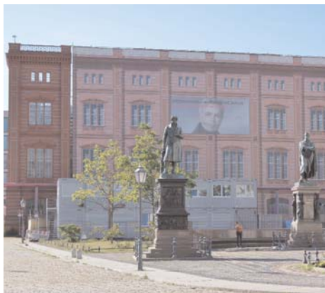
Die Schinkelsche Bauakademie kann mit Bundesmitteln fertiggestellt werden. Foto: Horb
