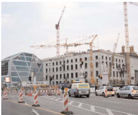
„Stadtschloss“-Baustelle: Richtfest soll Mitte Juni sein. Foto: Horb
