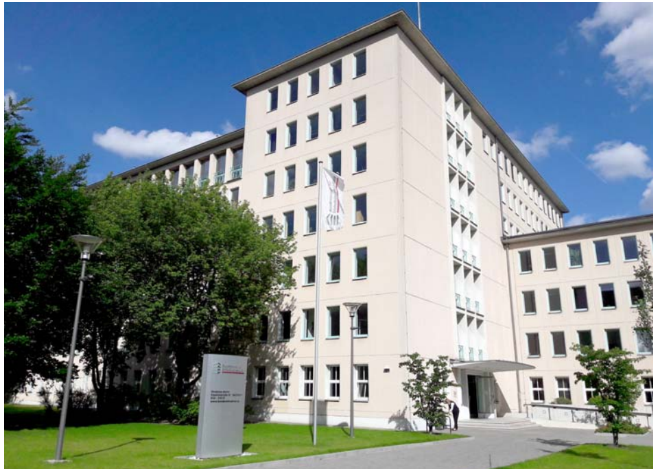
Das Gebäude der BlmA-Direktion in der Berliner Fasanenstraße
