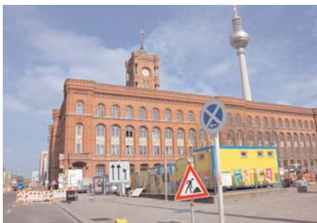
Rotes Rathaus: Baustelle am Parkplatz.
